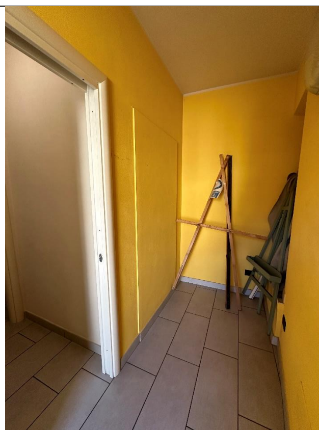
Predisposizione vano ascensore
