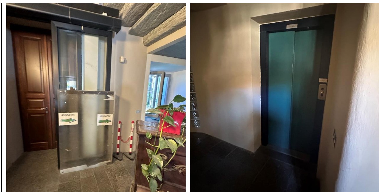
Ascensore nel Palazzo Comunale e indicazioni
