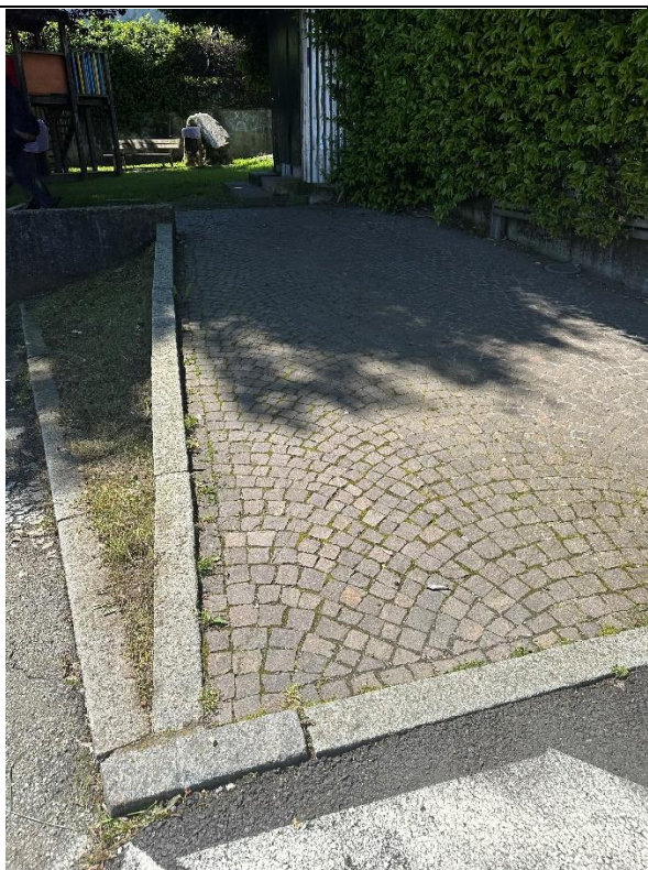
Rampa di accesso alla zona verde
