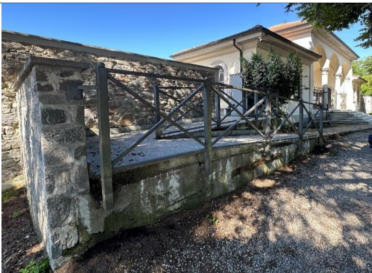
Rampa adll'ingresso principale
