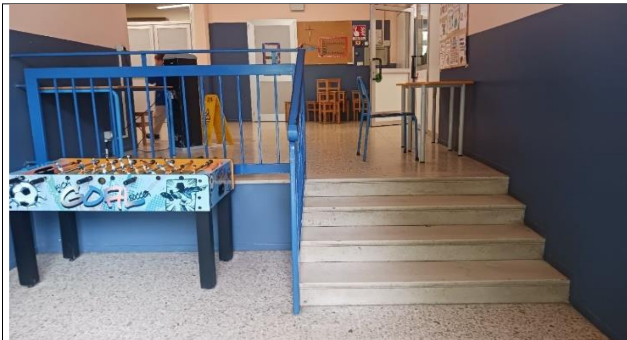
Ingresso retro – dislivello con scale
