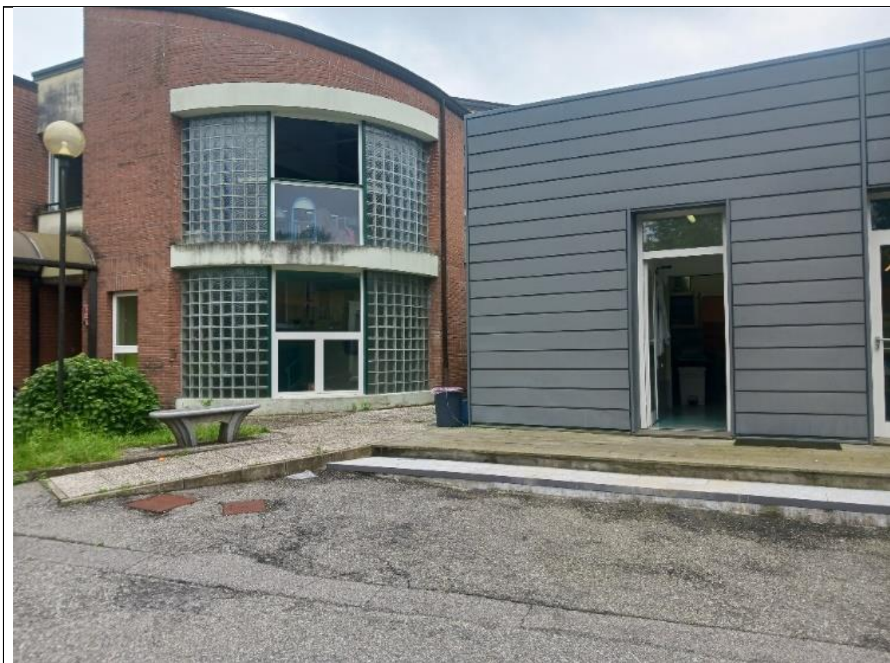
Ingresso nord – edificio scolastico e mensa
