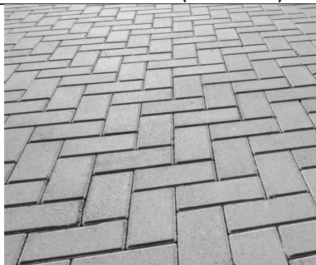
Pavimentazione in autobloccanti
