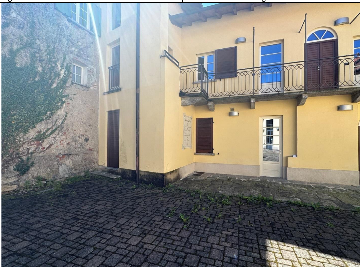
Cortile interno – ala Casa Curioni
